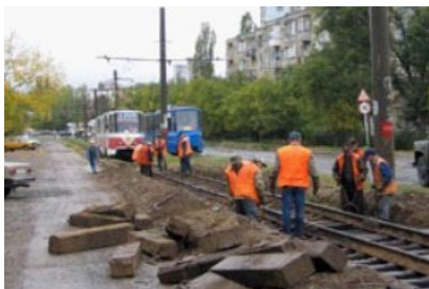
Планный ремонт ряда участков трамвайных путей
